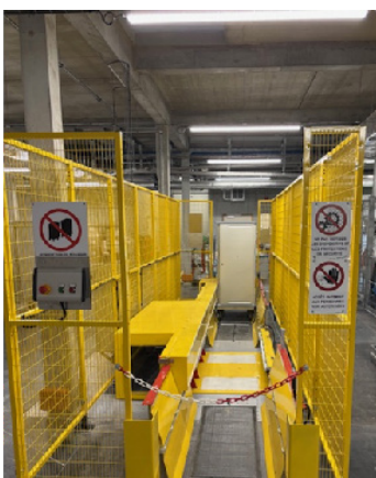
Photographies de l'intérieur de la nouvelle blanchisserie GIBA, mai 2026
